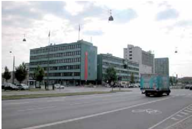
Falckhuset set fra Bernstorffsgade (eksisterende forhold)
