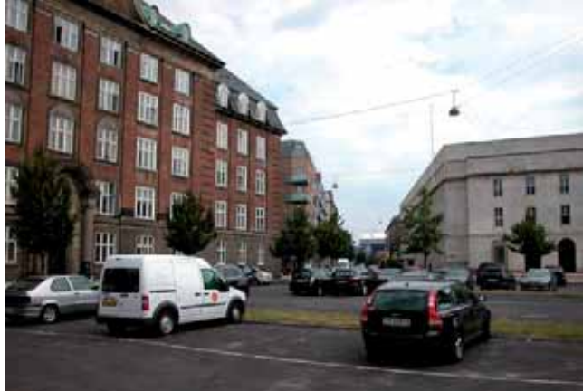
Polititorvet set fra Bernstorffsgade (eksisterende forhold)
