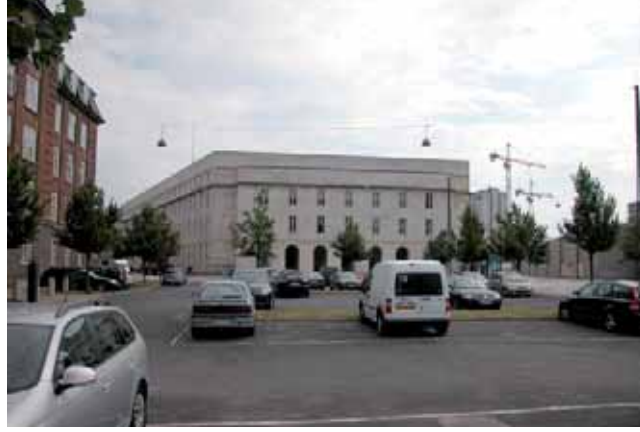
Polititorvet set fra Bernstorffsgade (eksisterende forhold)
