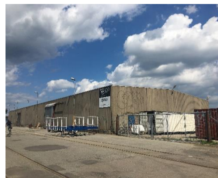
Eksisterende lagerhal ved Kalkbrænderiløbskaj. Forrest ses den nuværende belægning med asfalt og jernbaneskinner.
