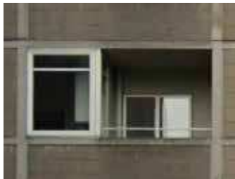
Reference til eksisterende: SAB 2
