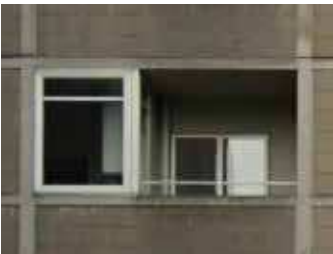
Reference til eksisterende: SAB 2
