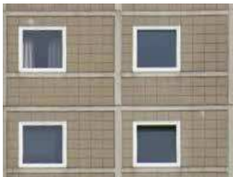
Reference til eksisterende: SAB 1
