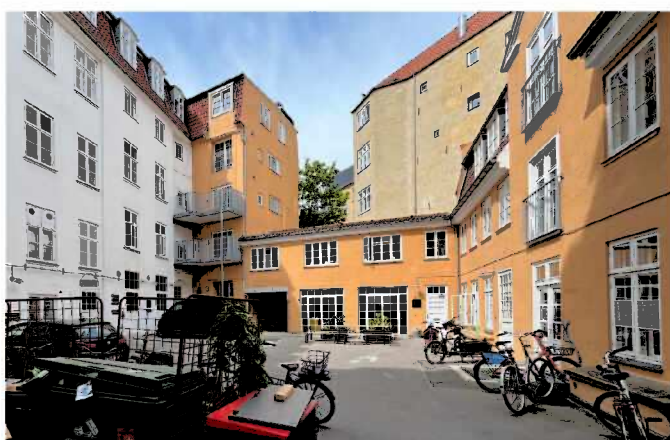
Billede fra stedet – Eksisterende gårdtrum og bygninger. Blik mod nord. Hvid bygning er nr. 32. Høj gul bygning til venstre er nr. 32A. Lav gul bygning er nr. 30C. Mellem-høj gul bygning er nr. 30A-B.
