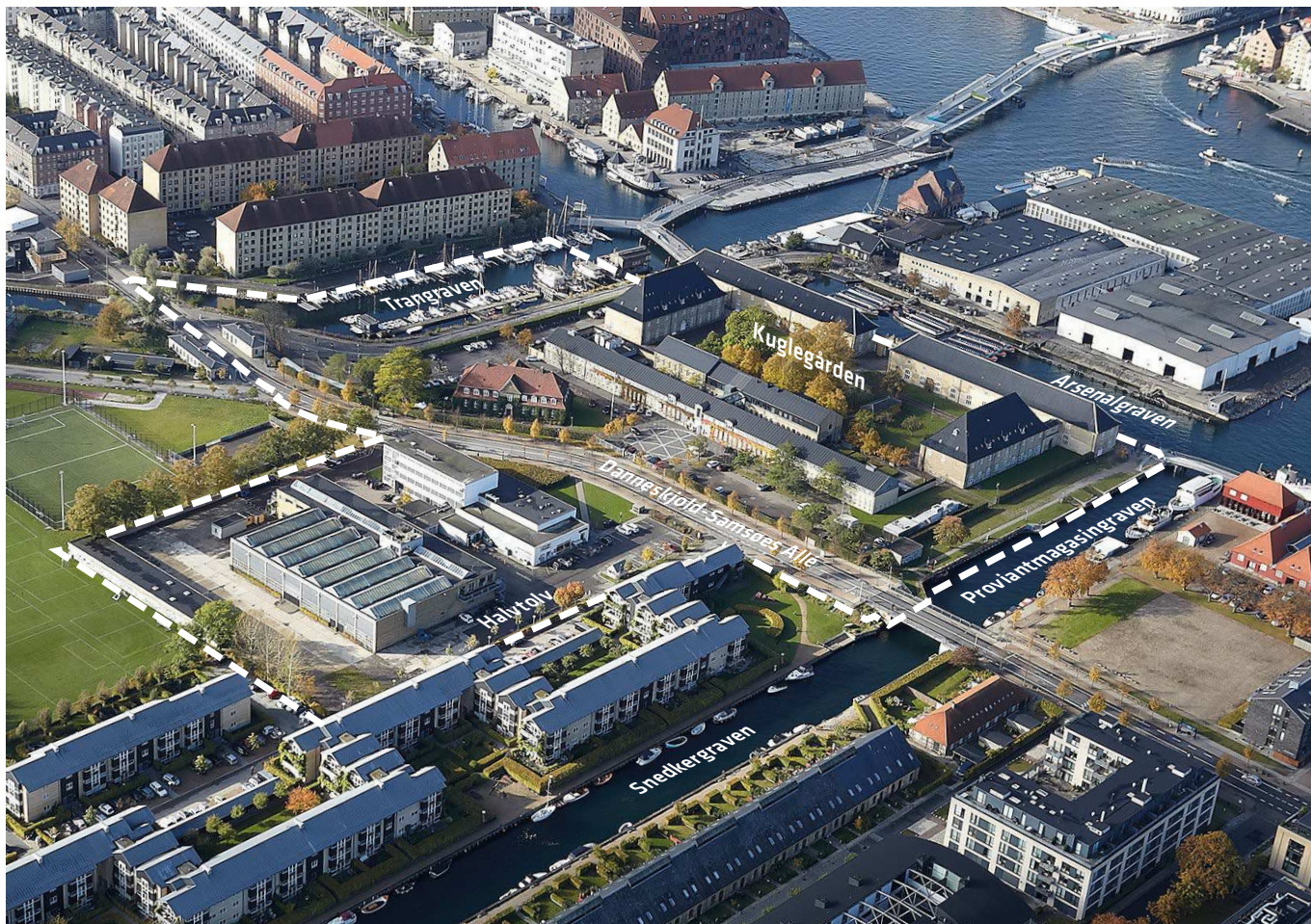
Skråfoto af lokalplantillægsområdet. JW Luftfoto, oktober 2016.
