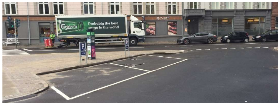
Foto 2: De højresvingende skal i dag køre igennem p-plads der er forbeholdt handicapparkering kl. 6-16.
