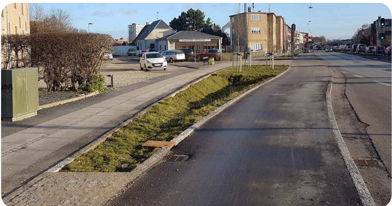
Regnvandsbed i Folehaven
