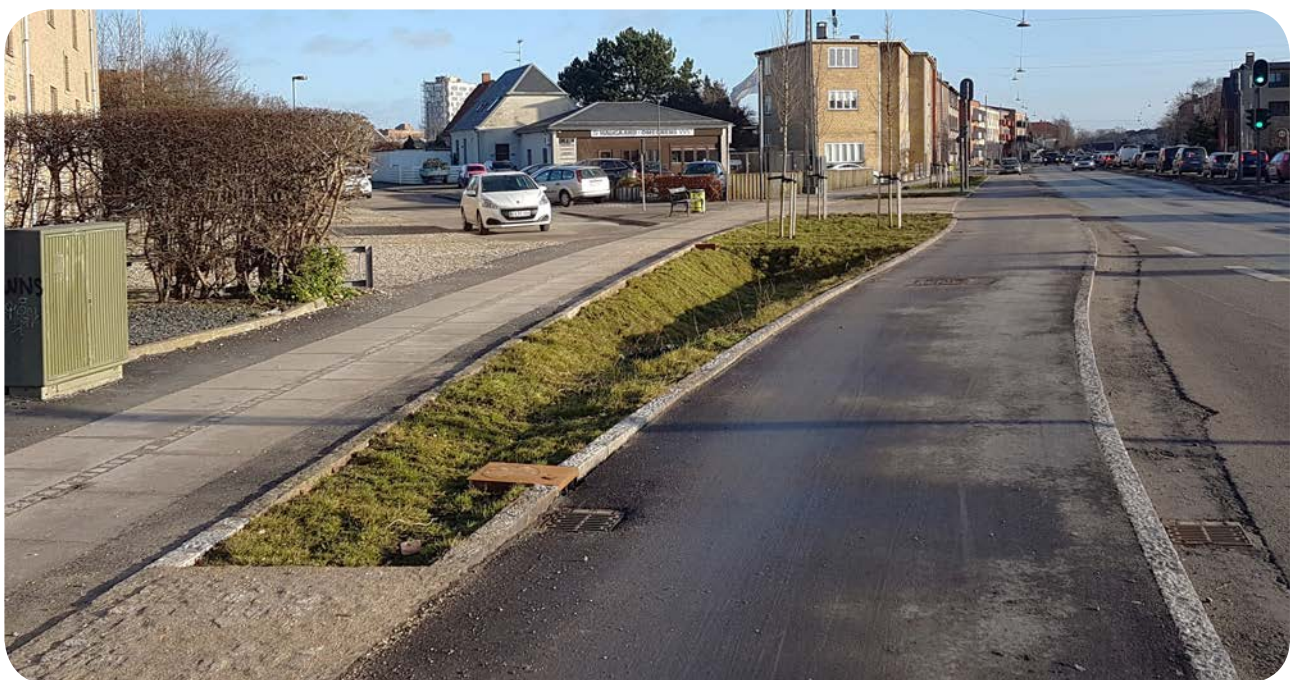
Regnvandsbed i Folehaven
