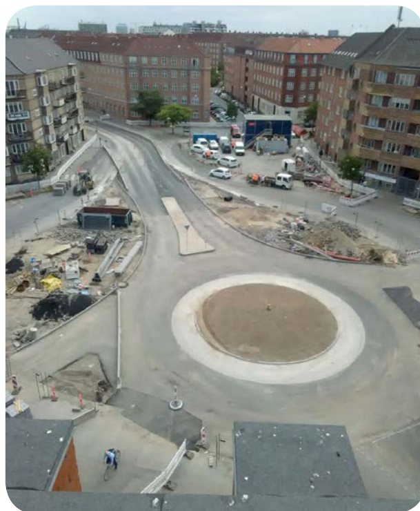
Anlægsarbejde på Skt. Kjelds Plads
