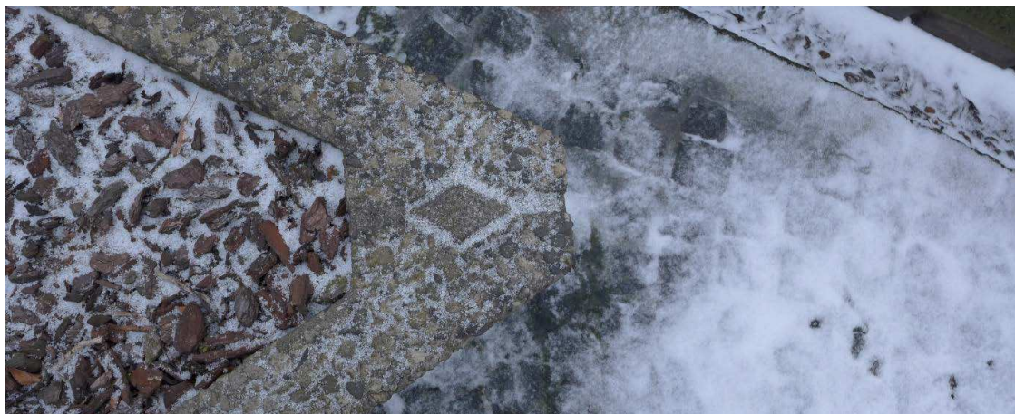
Plantekasserne i samme søstensbeton som facaderne. Kasser er fint detaljerede. Foto G. Pontoppidan 2018.
