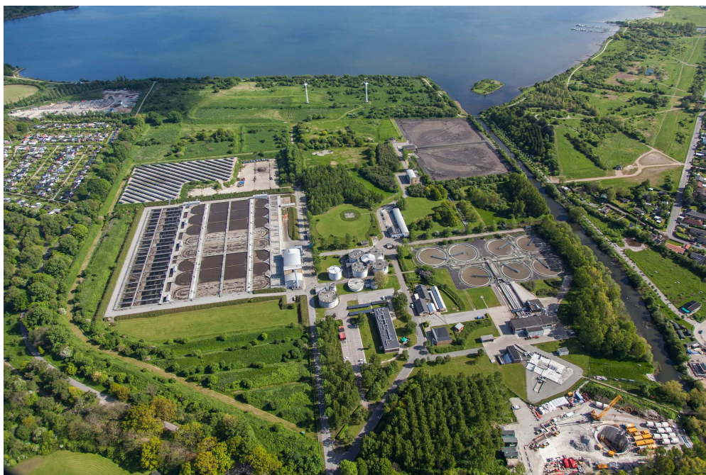
Renseanlæg Damshusåen. Foto: Hviid Photography
