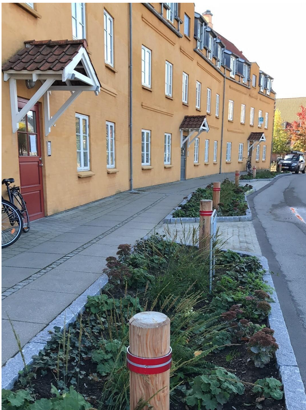
Vejbed til forsinkelse og nedsvivning af regnvand på Erik Ballings Vej. Foto: Louise Madsen
