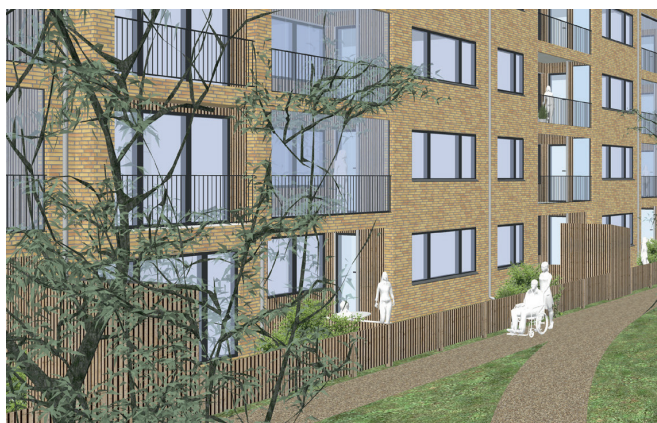
Nye facader med skalmur i tegl samt nye forhaver og nye altaner
