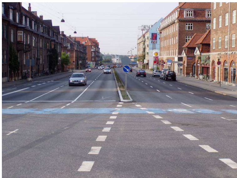
Strækning af Lyngbyvej hvor der er udlagt støjreducerende asfalt. Kommunen vil evaluere effekten via målinger og spørgeskemaer til de omkringboende.
