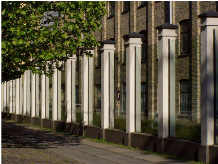
Eksempel på en smukt tilpasset lokal støjskærm i glas, Smallegade, Frederiksberg
