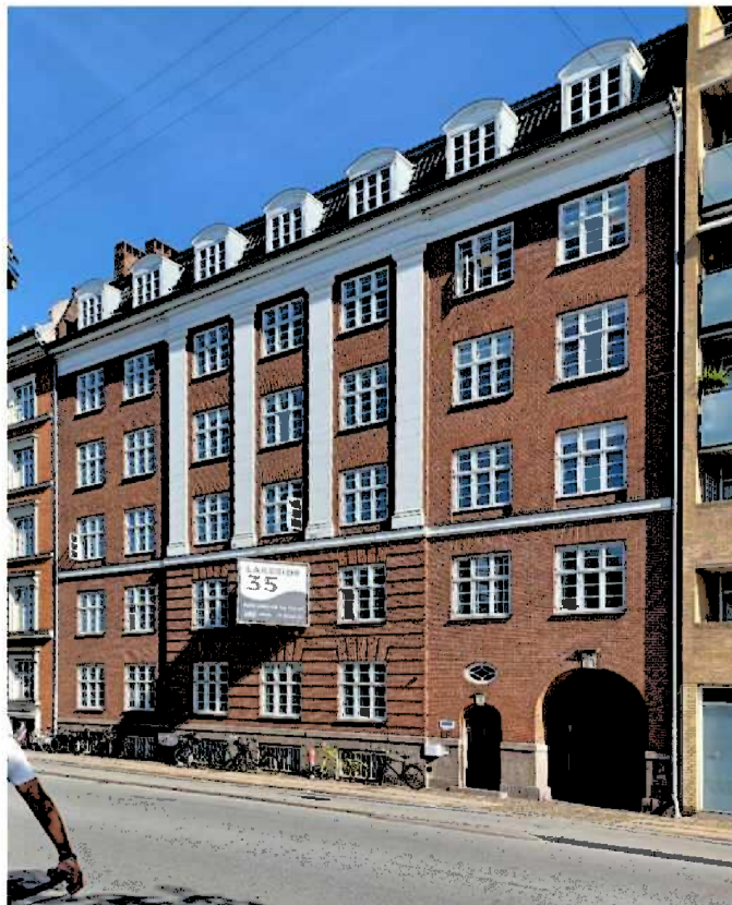
Facade mod Nørre Søgade.
