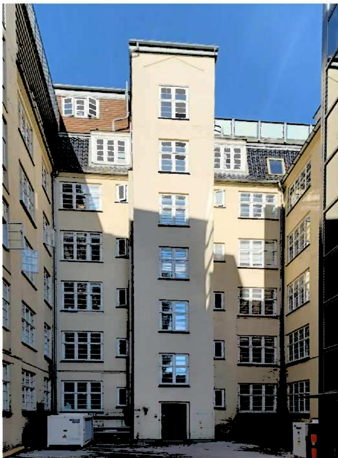
Mellemhusets facade set fra gårdrummet.
