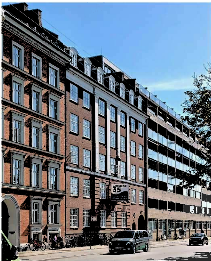
Facade mod Nørre Søgade.
