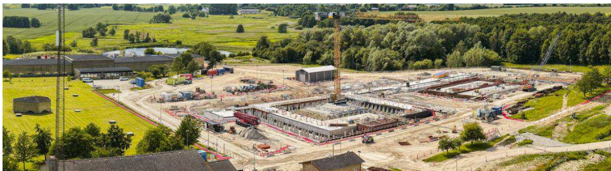
Figur 2. Opførelsen pågår. Kælderkonstruktioner og fundering er afsluttet, og nu pågår terrænarbejder samt meget snart elementmontage
