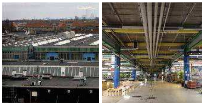
Grønttorvshallen udefra (tv.) og den indvendige konstruktion, der bevares delvist. Fotos: Polyform.
