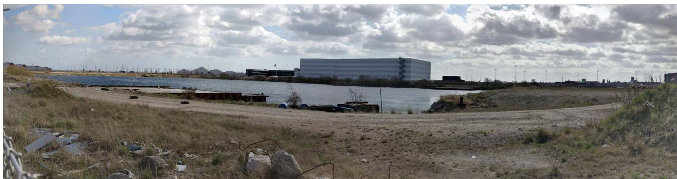
Panorama af hele tillægsområdet set fra nord mod sydøst, med Unicefs Højlager begved og til venstre længere i baggrunden krydstogtterminalen.
