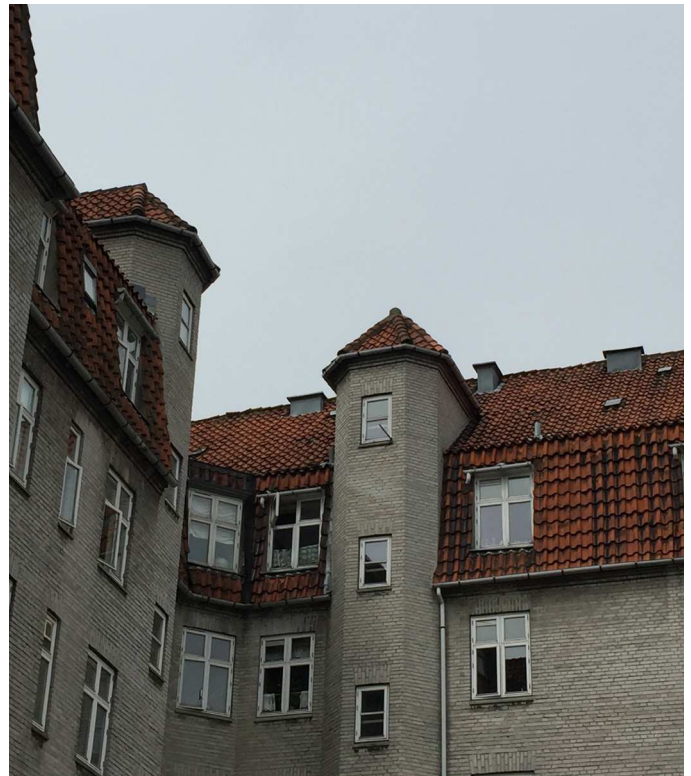
Eksisterende tag er nedslidt og udskiftes.
