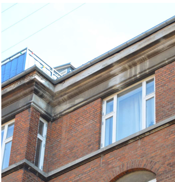
Vinduer udskiftes og facade renoveres.
