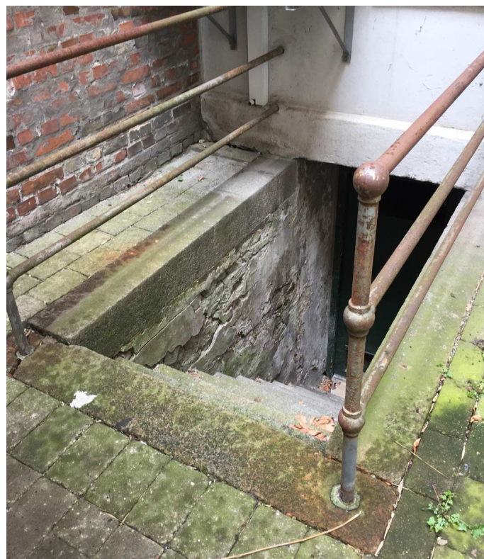
Ejendommen skybrus sikres med omfangsdræn og opkanter.
