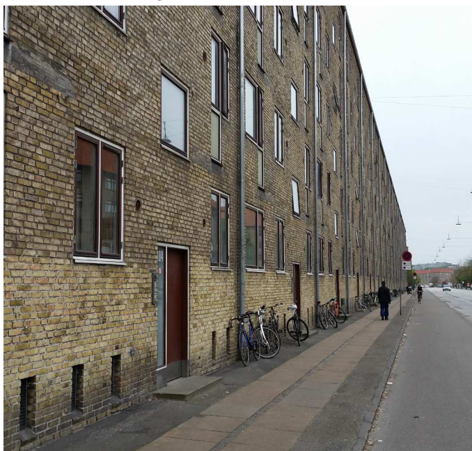
Ejendommen set fra gaden.
