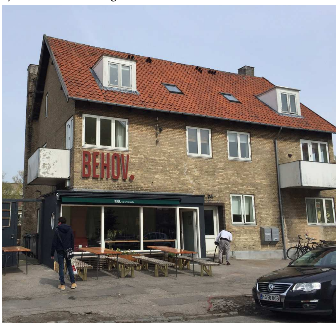
Ejendommen set fra gaden.
