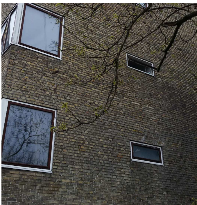
Vinduer udskiftes og lydisoleres.
