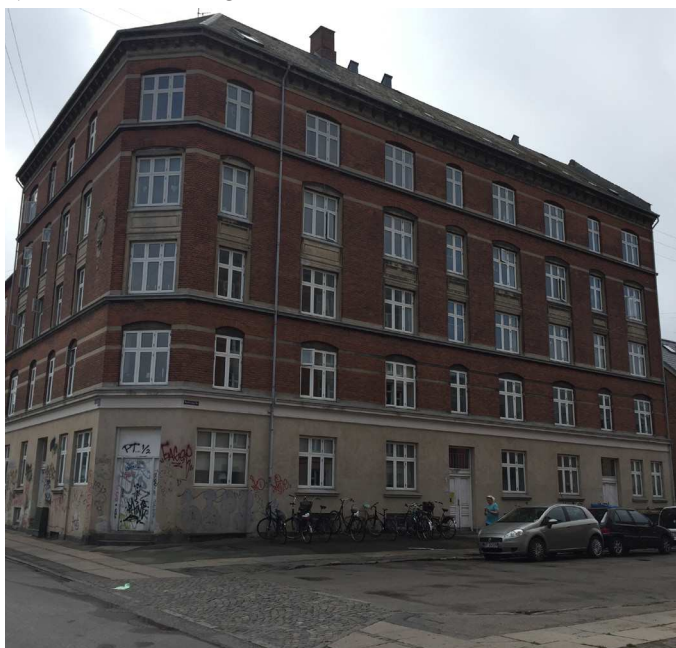
Ejendommen set fra gaden.
