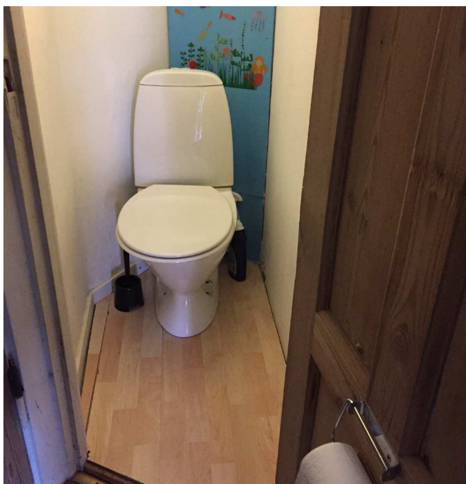
Utidssvarende "bak-ind" toilet uden bad.
