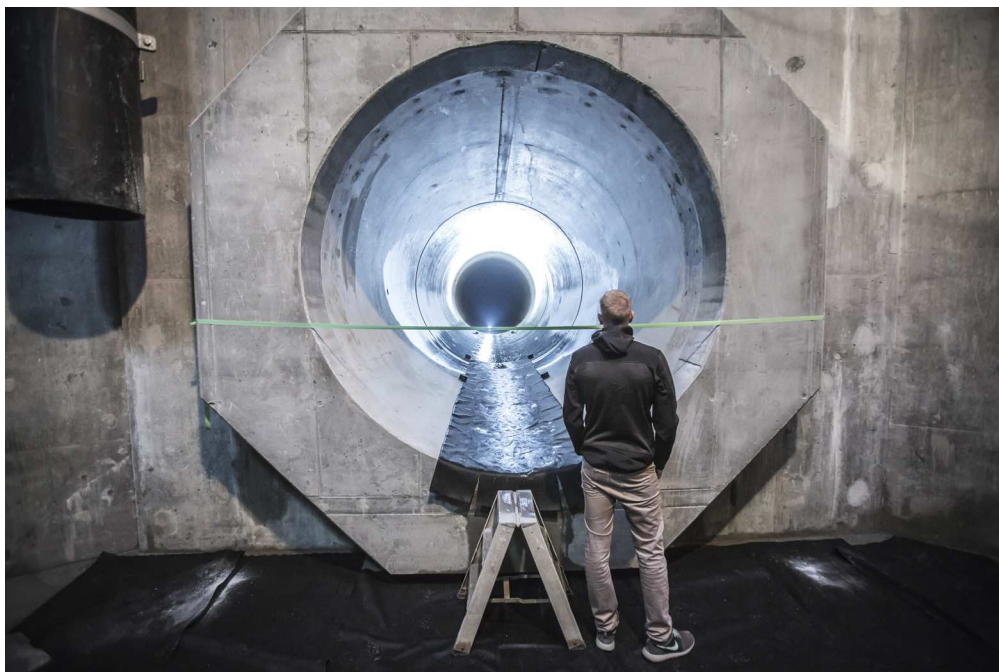
Østerbro skybrudstunnel. Foto: HOFOR
