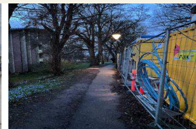
Arbejdsvogn til vejarbejde
