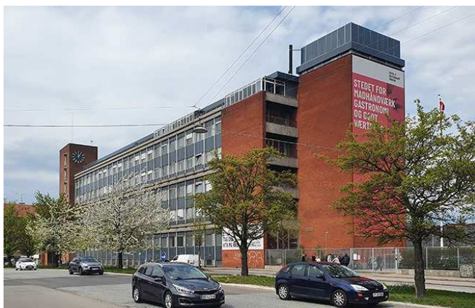
Randbebyggelsen langs Vigerslev Allé med sin markante hjørnemærkning med bl.a. ur. Billedet er taget fra sydøst midt på Vigerslev Allé.
