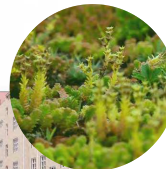
Badmintonhallen blekædes med sedum.
