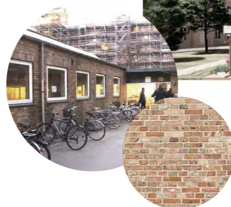
Genbrugstegl fra den nedrevet tilbygning
