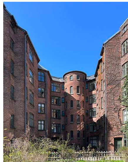
Blågårdsgade 21 – facade mod gården.
