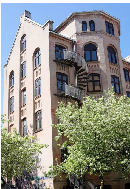
Bygningen, som tidligere var Blågårds Seminarium.
