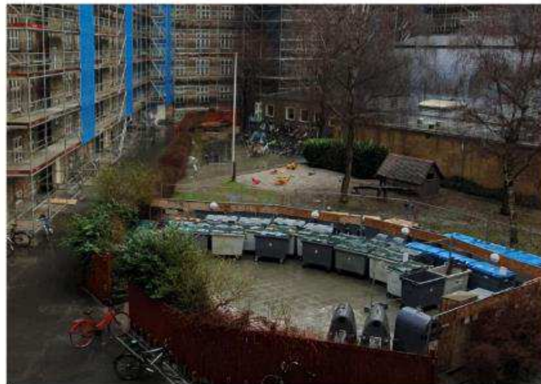
Gårdrum 2023: Fflisebelagt cykelparkering og containerplads
