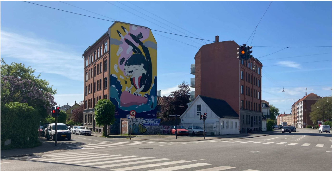
Vejkrydset ved Englandsvej 21, hvor Torben Oxes Allé fører ned til Eberts Villaby. Fra denne vinkel ses også det grønne gårdmiljø der allerede er eksisterende i gården bag til Englandsvej 21. Foto: Over Byen Arkitekter.
