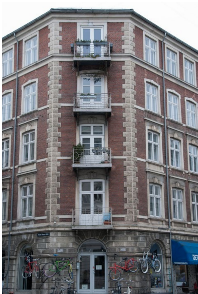
Foto 22. Eksempel på nye altandørpartier, hvor der ikke er blevet koordineret mellem de forskellige boliger, så alle dørpartierne har fået forskellige udtryk.
