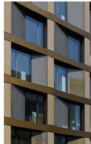
Eksempel på facadeparti i metal og glas: Freischütz-gasse House, Zürich. Arkitekt: David Chipperfield.
