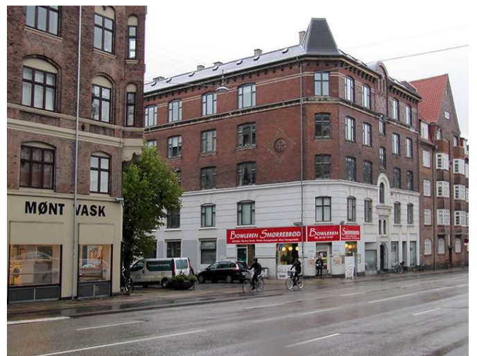
Baldersgade set fra Tagensvej.
