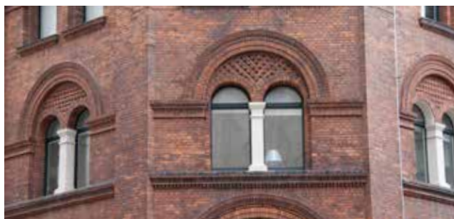
Tordenskjoldsgade 1 er et eksempel på den danske pendant til den tyske Rundbogenstil, rundbuestil.
