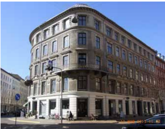
Foto 9. Facadedetaljeringen som dekorationer, gesimser og lignende skal opleves gennem forskellige materialer eller skyggeeffekten og ikke ved at fremhæve dekorationerne med en malerbehandling i anden farve.
