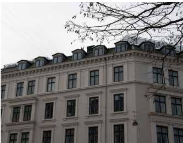
Foto 16. To tagterasser placeret på den flade del af Københavnertaget. Tagterassen til højre er meget synlig, mens tagterassen mod venstre er mere diskret placeret. Det er ønsket, at en tagterasse ikke kan ses fra gadesiden.
