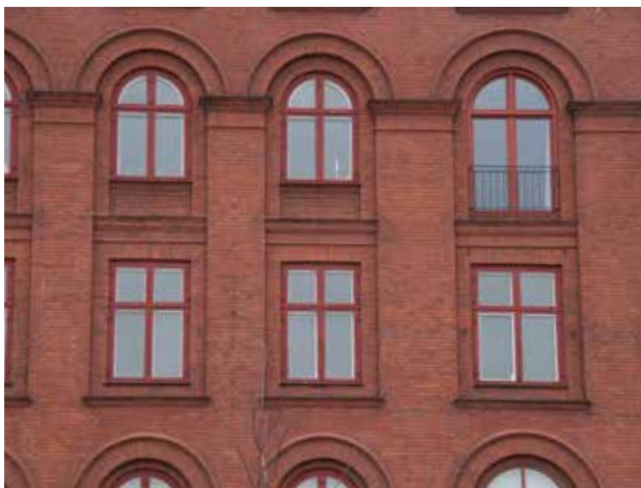
Foto 20. En fransk altan kan i nogle tilfælde være en løsning i stedet for en rigtig altan. I dette tilfælde er den franske altan placeret alene, og facaden vil få et mere homogent udtryk, når de øvrige felter også får etableret franske altaner.
