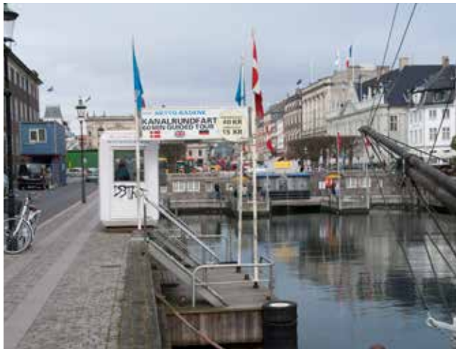
Anløbsbro i Nyhavnskanalen med markant skiltning, som skæmmer den bevaringsværdige kajkant og nyanlagte promenade.
