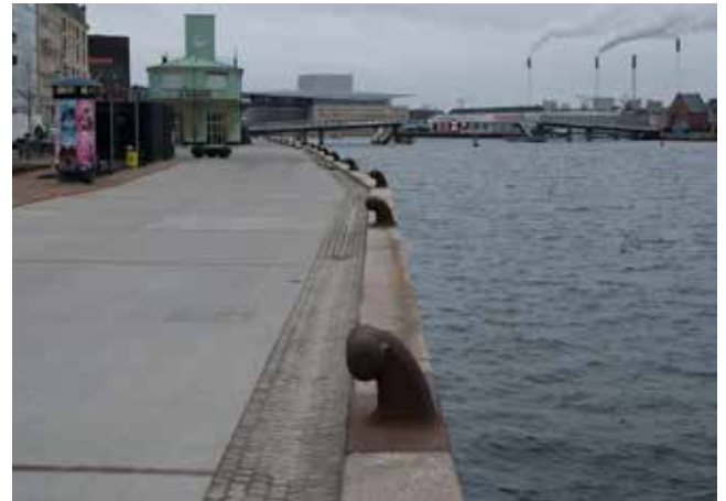
Bolværket mod havneløbet er udført med lodret kajmur og bolværkshammer i granit, hvilket er typisk for Inderhavnen.
