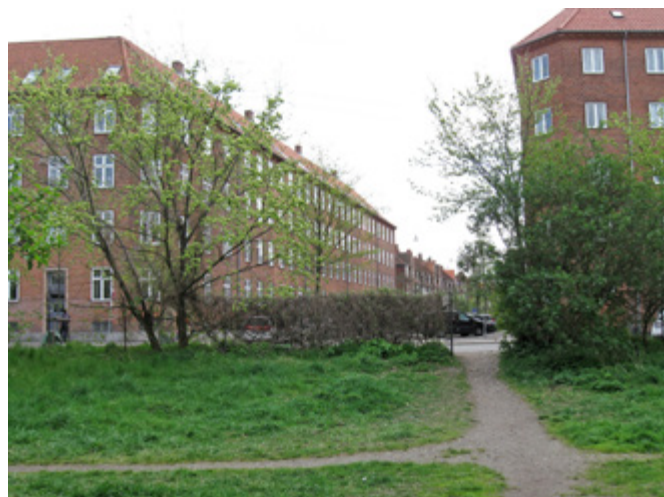
Billede fra Beauvaisgrunden mod Engelstedsgade.
