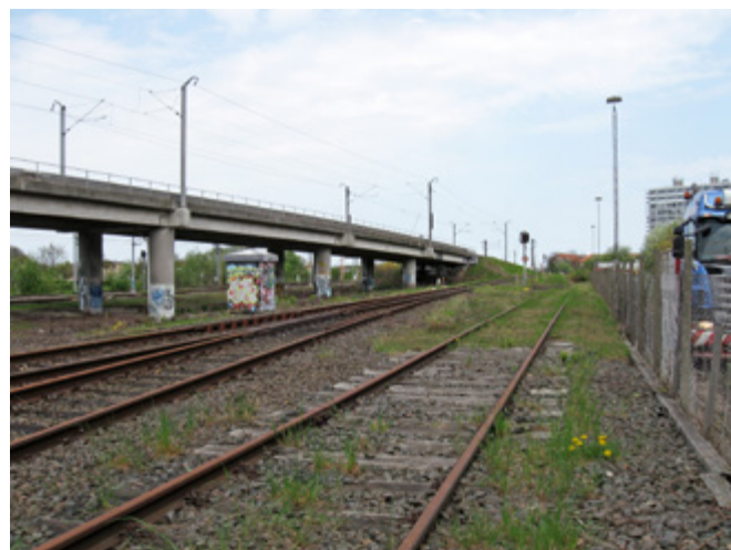
Jernbanespor - og bro - nord for Beauvaisgrunden.
