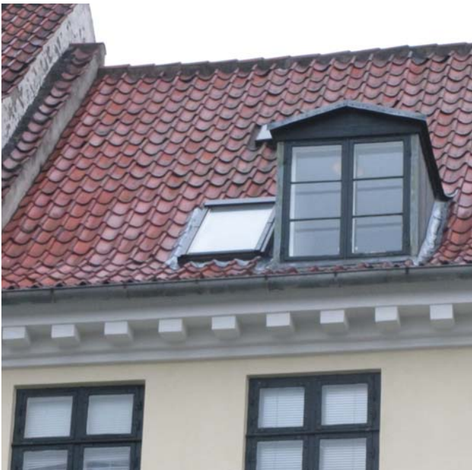
Tag totalrenoveres og efterisoleres på forhus
