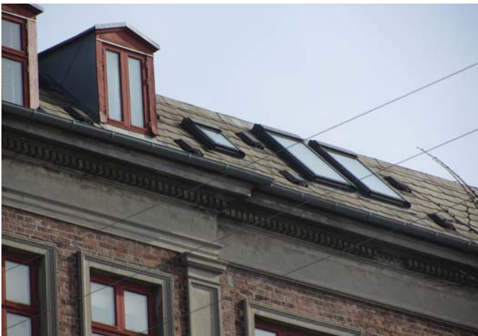
Nedslidt tagbeklædning skiftes og der efterisoleres
