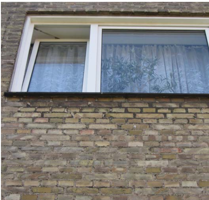
Vinduer og altandøre udskiftes
