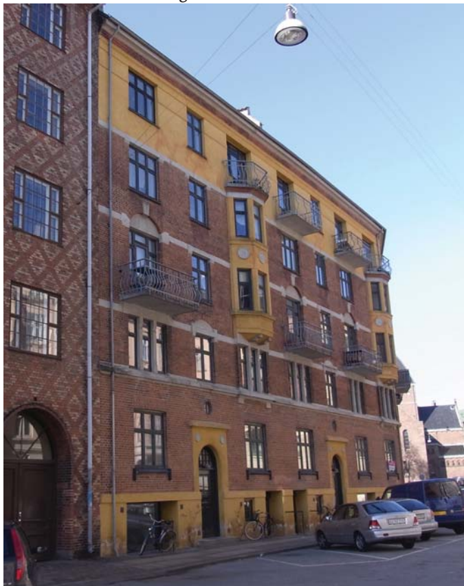
Facade mod Henrik Rungs Gade. Vinduer istandsættes
