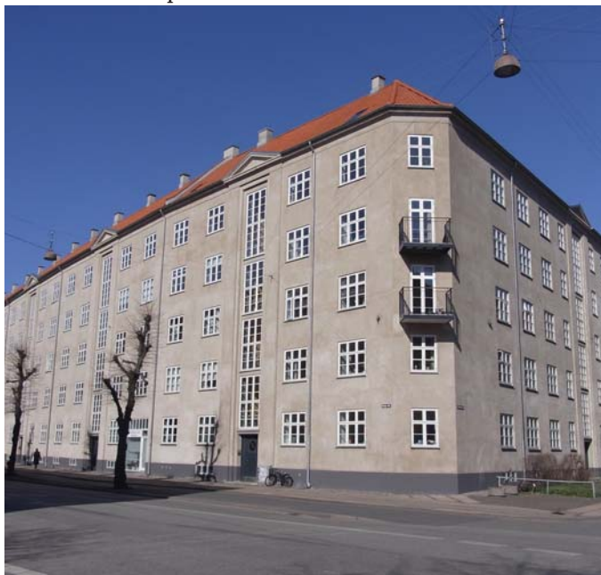
Facade mod Borups allé. Varmtvandsrør efterisoleres.
