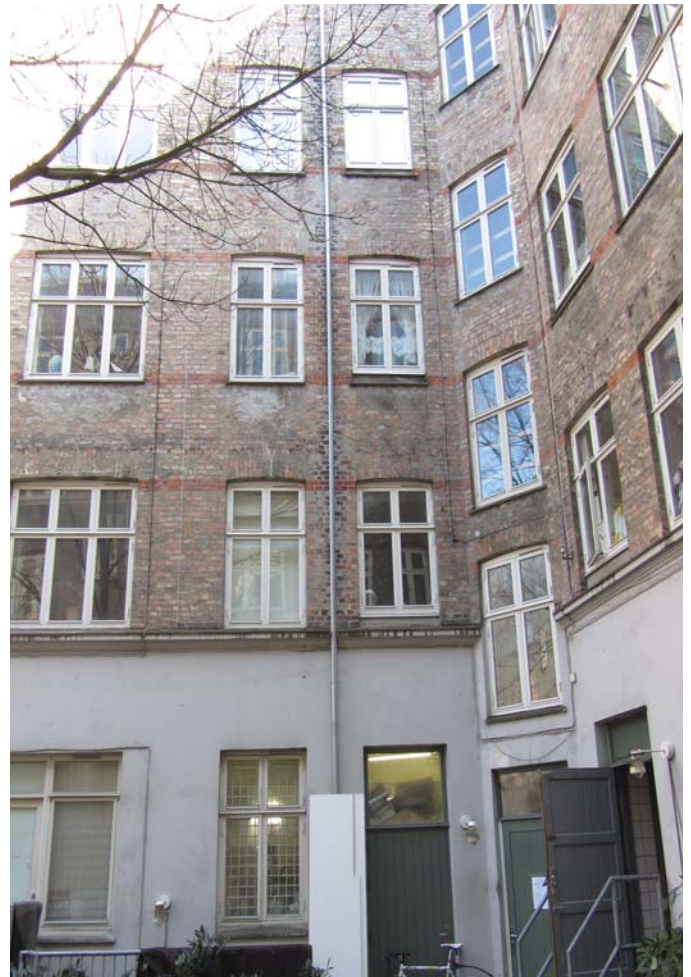
Facade mod gård eftergås og vinduer udskiftes
