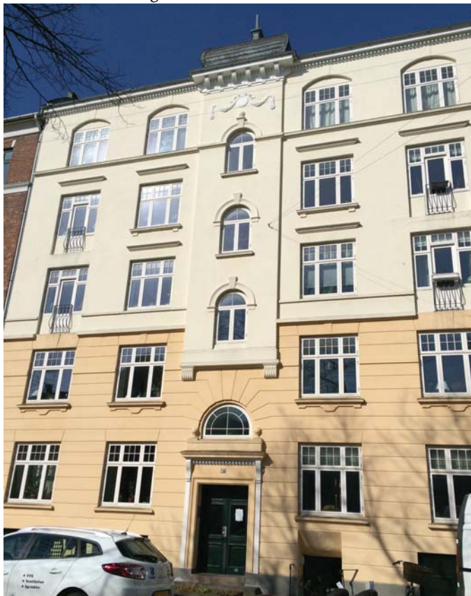
Facade mod Baldersgade istandsættes ved tidl. altaner
