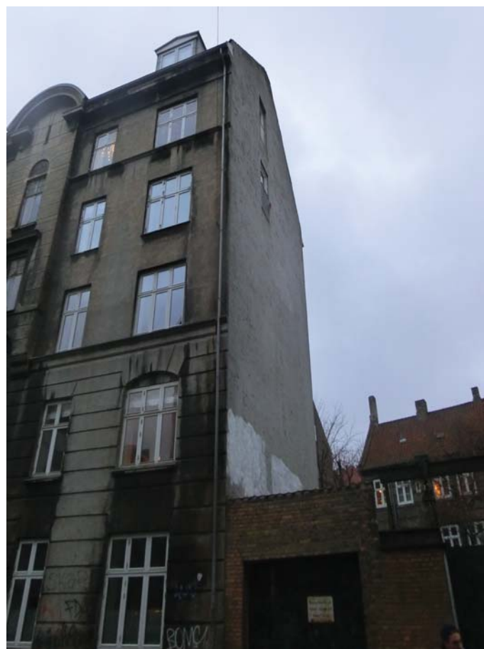
Sidste gavl af i alt fire efterisoleres udvendigt
