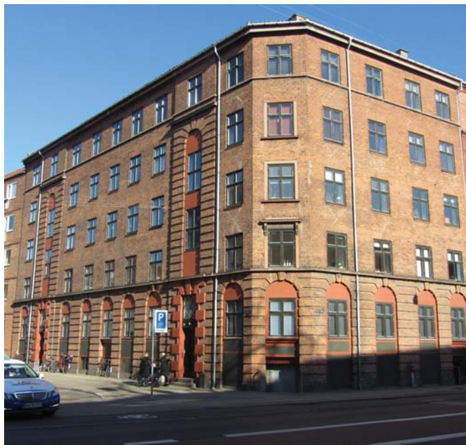
Facade mod Kurlandsgade og Sundholmsvej
