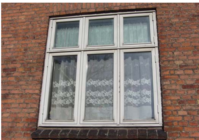
Gamle termovinduer udskiftes og energioptimeres
