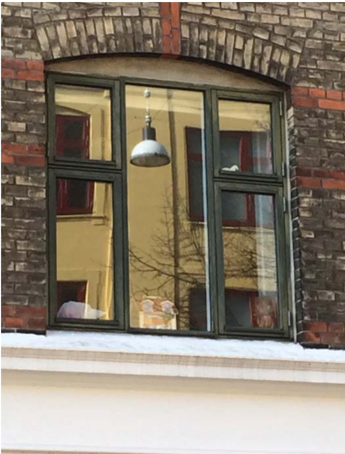
Termoruder med stort energispild udskiftes
