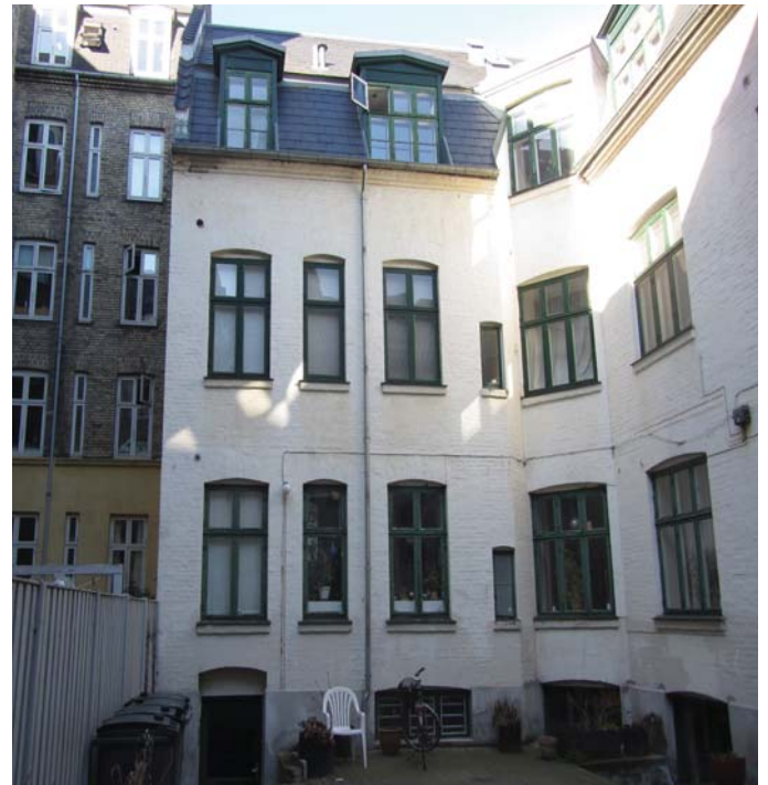
Facade mod gård istandsættes og efterisoleres udvendigt
