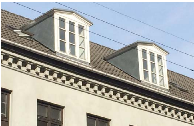
Tag efterisoleres indvendigt
