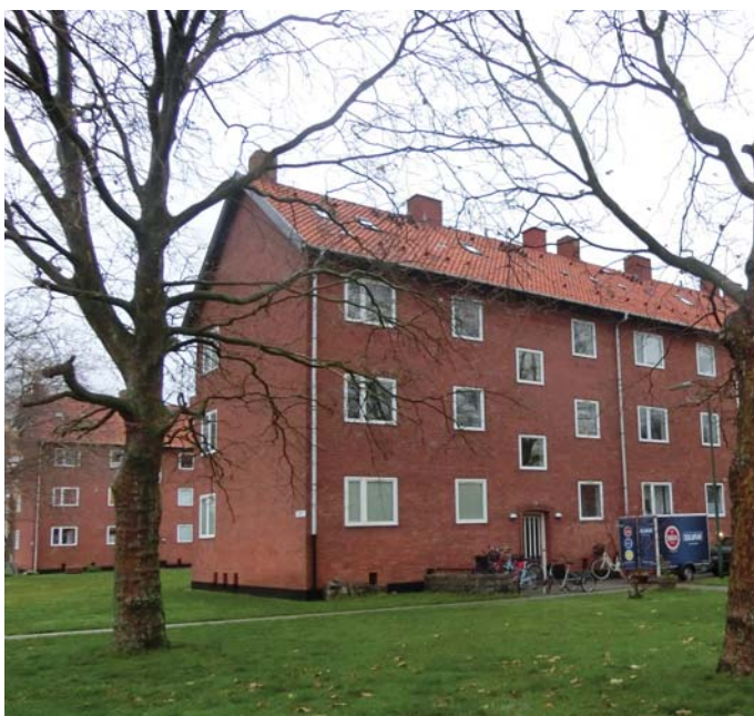
Facade mod Hendonvej
