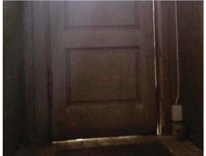
Store utætheder på bagtrappedøre tætnes og istandsættes
