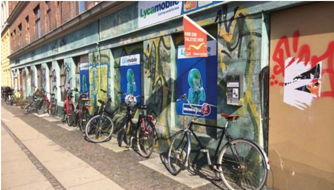
Underfacade istandsættes og lyskasser nedlægges pga. fugt
