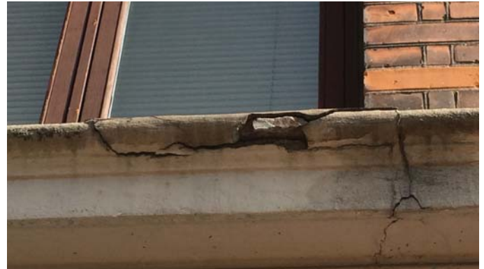
Vinduer istandsættes og energioptimeres og facader tættes
