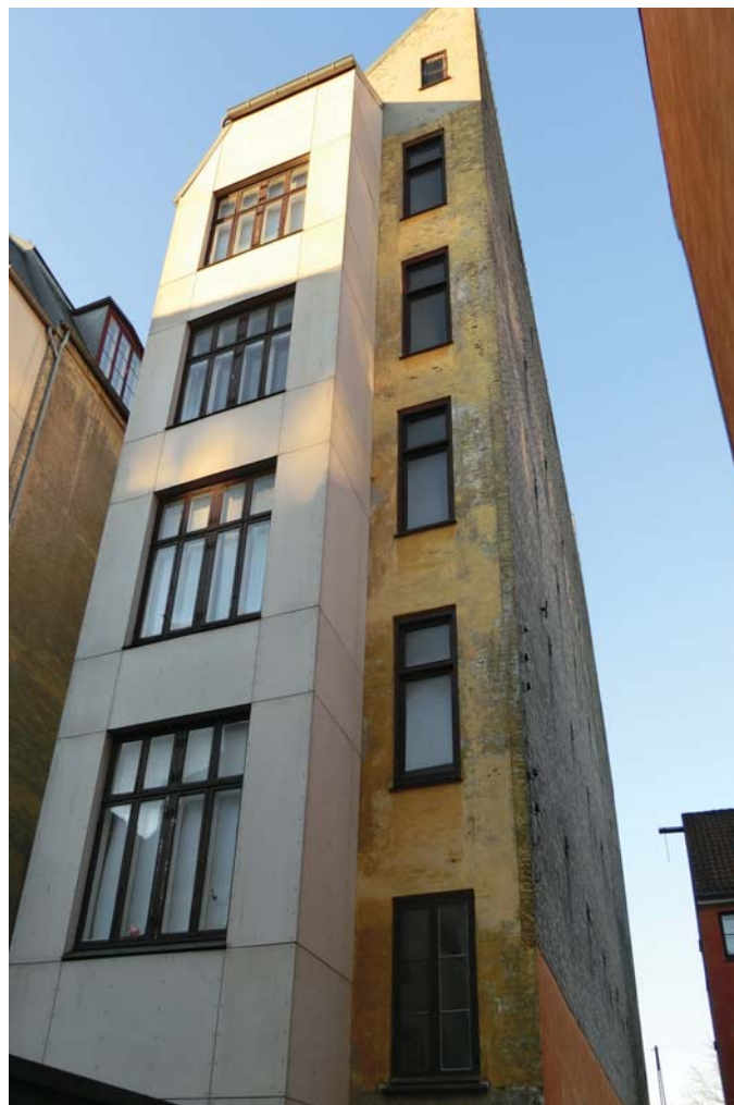
Efterisolering af gavle
