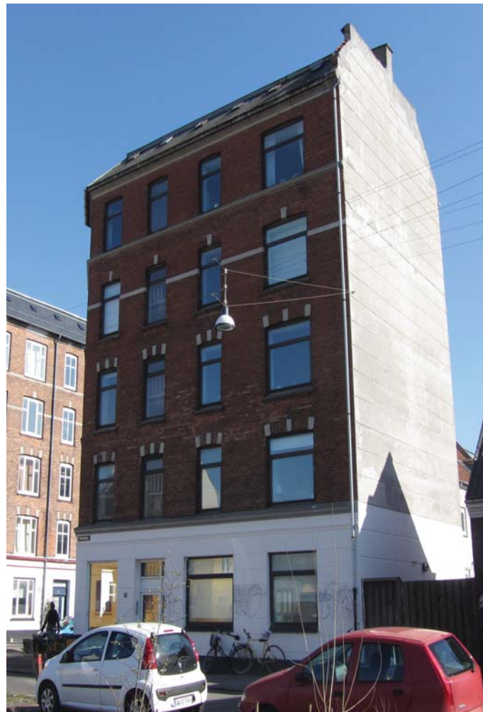
Facade mod Provstevej. To endegavle isoleres udvendigt
