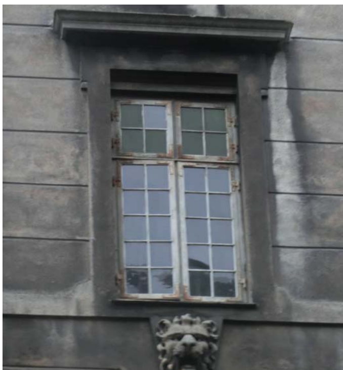
Nedslidte vinduer i trappegange mod gade istandsættes Facade mod Brobergsgade afrenses, istandsættes og begrønnes
