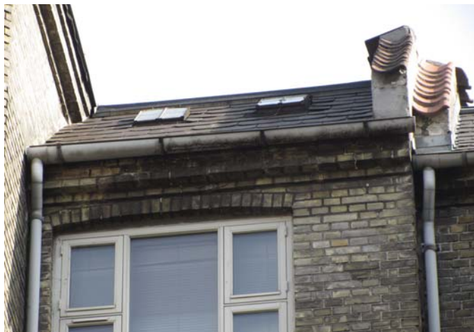
Tagkonstruktion renoveres, og der lægges nyt skifertag
