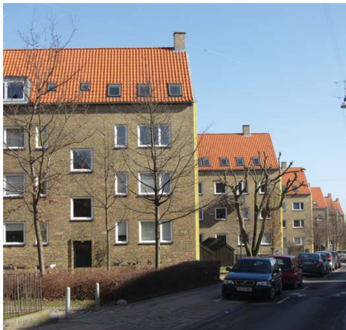
Facade mod Møntmestergade
