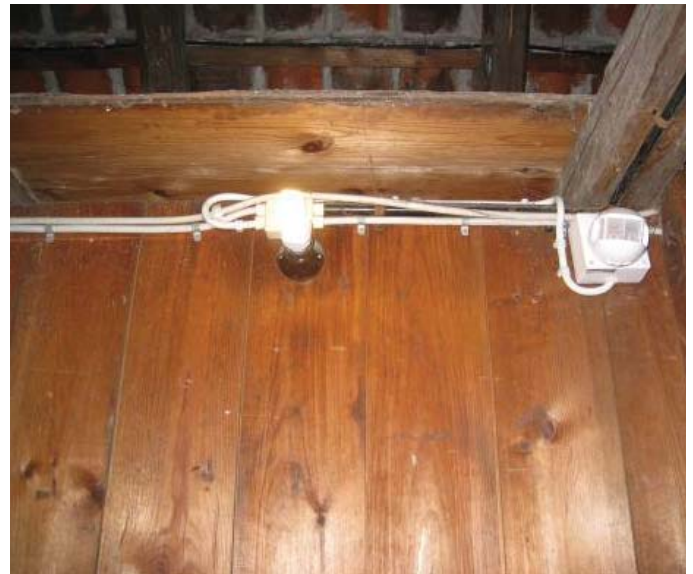
Udskiftning til energibesparende lysarmaturer i kælder
