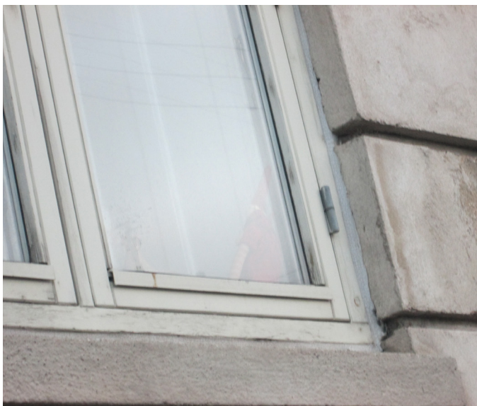
Udsnit gammelt termovindue
