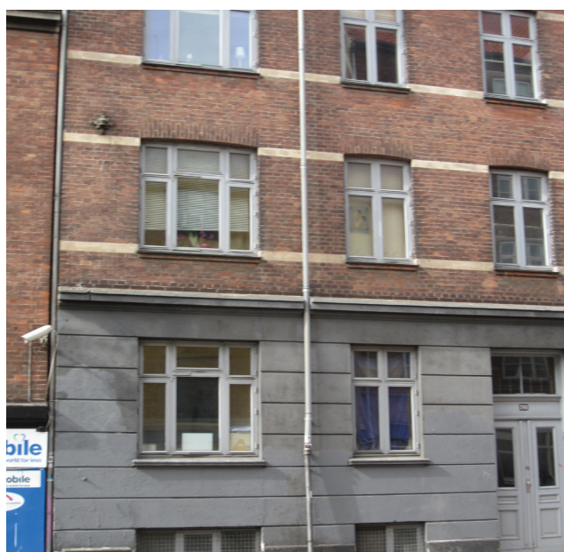
Facaden istandsættes og fugerepareres
