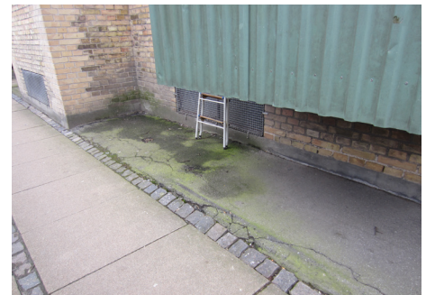
Efterisolering af etageadskillelse mod kælder
