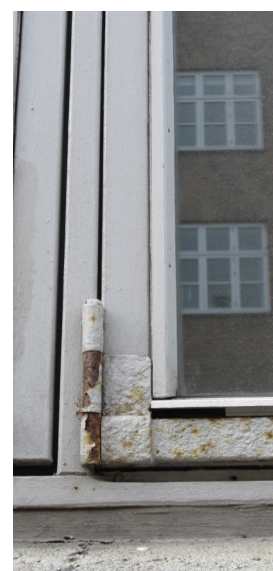
Vinduer udskiftes og energi- og støjoptimeres
