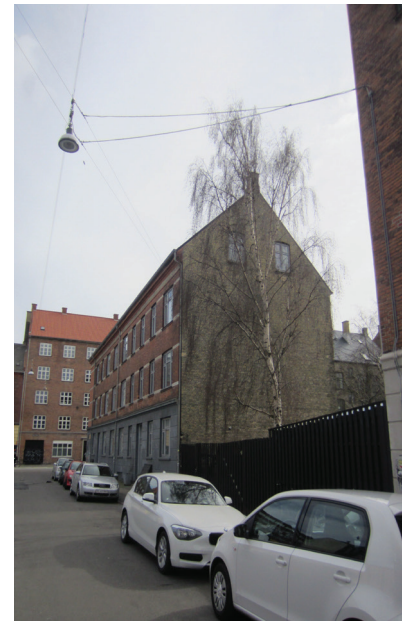
Isolering og begroening af gavl
