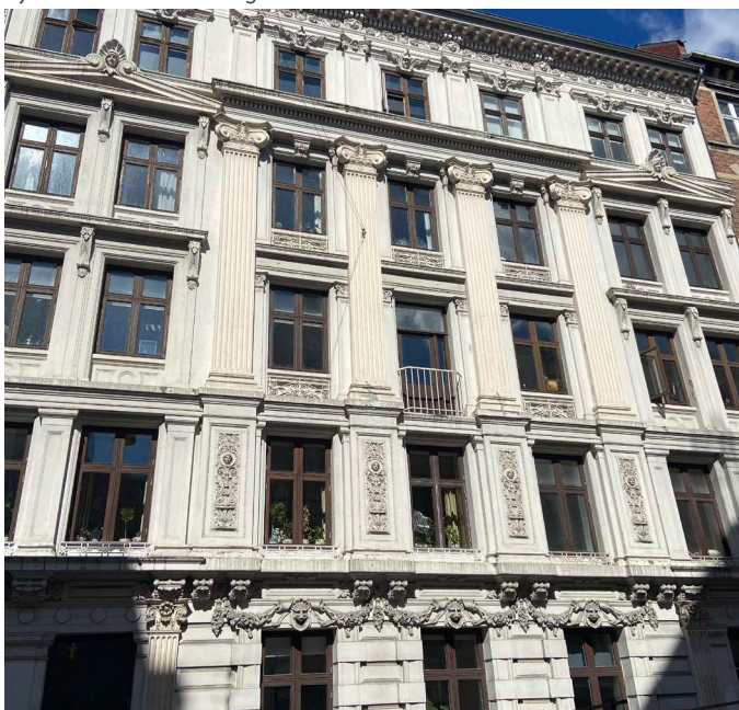
Ejendommen set fra gaden
