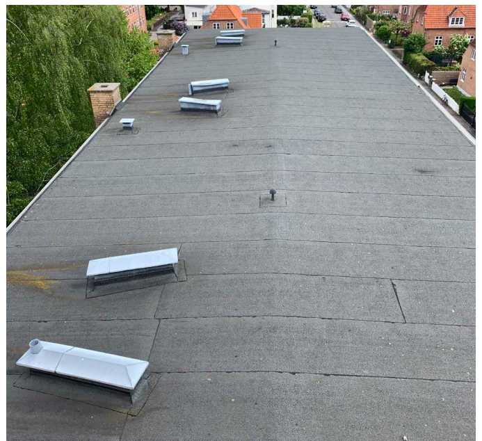
Fladt tag hvor der bliver etableret solceller
