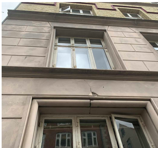
Eksisterende vinduer og underfacade
