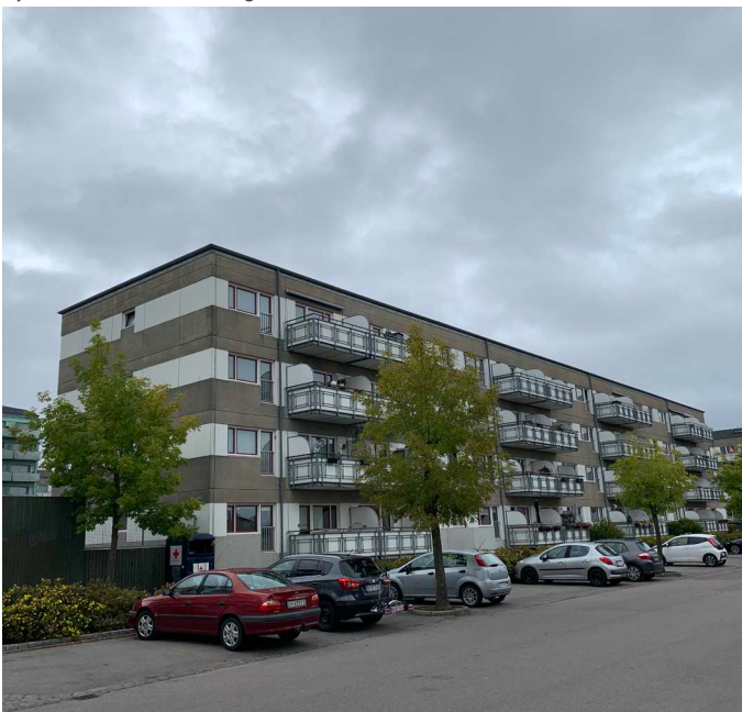
Ejendommen set fra gaden
