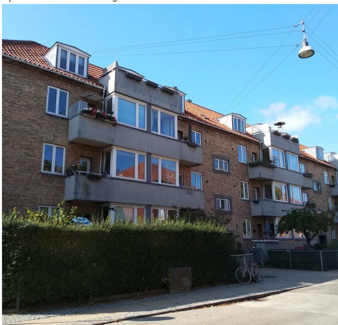
Ejendommen set fra gaden
