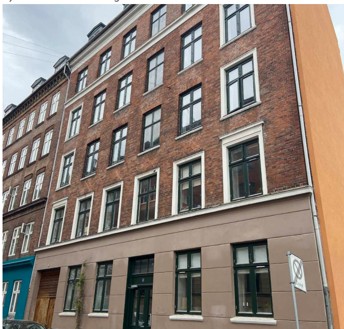
Ejendommen set fra gaden
