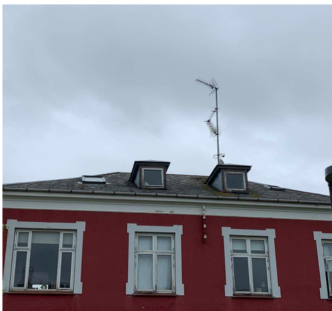
Etablering af ny tagkonstruktion med 2 tagboliger
