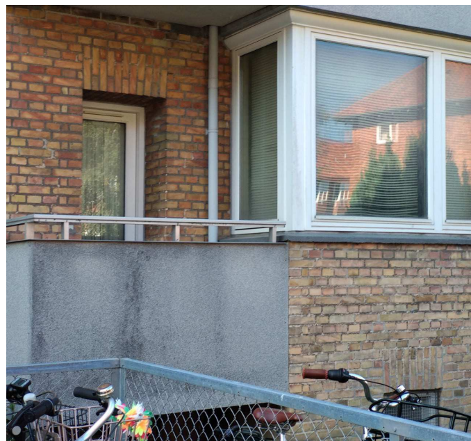
Eksisterende altan- og vinduesparti
