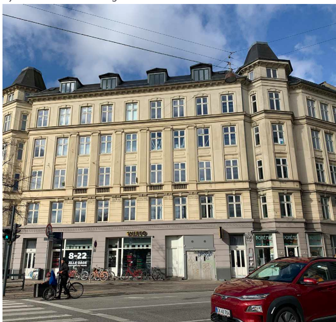
Ejendommen set fra gaden
