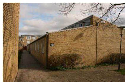
Institutionsbygninger i 1 etage og med forskudte tage
