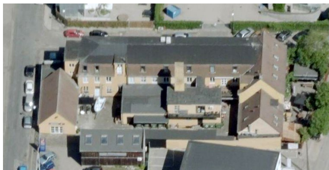
Gørtlervej 2-4/Lygten 29, der udpeges som bevaringsværdig
