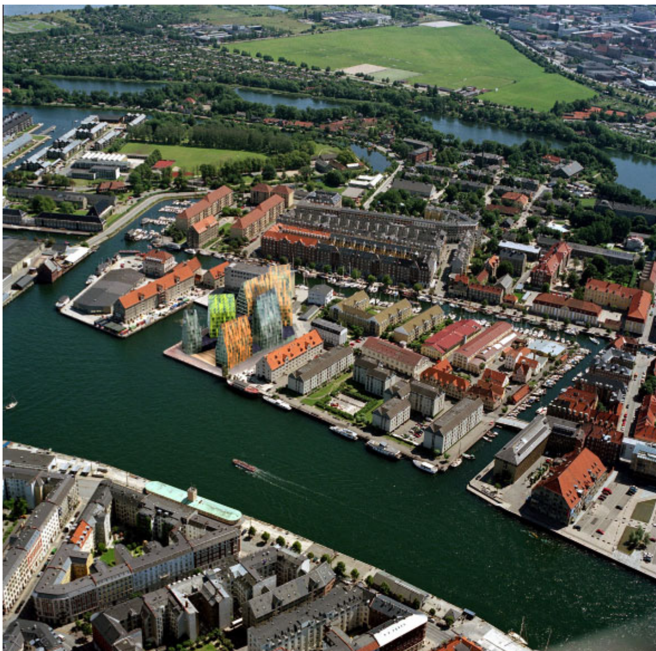
Luffoto set mod øst, hvor bebyggelsen ses i sammenhæng med den eksisterende bebyggelse på Wilders Ø og Christianshavn.
