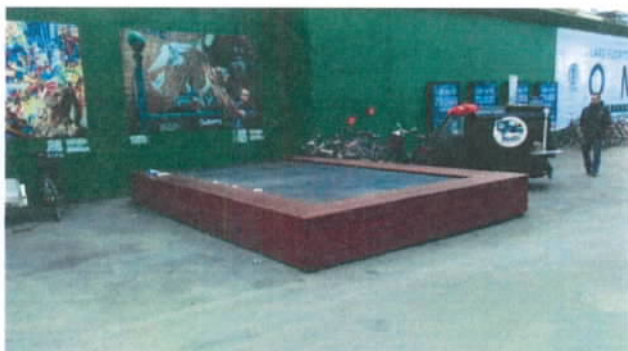
Figur 7 I 2015 fik Miljøpunktet bevilliget eksterne fondsmidler til at etablere et grønt tag på toppen af en endnu ikke færdig bygget elevatorskakt i forbindelse med Byens Hegn på Kongens Nytorv. Taget bliver anlagt ultimo april 2016.
