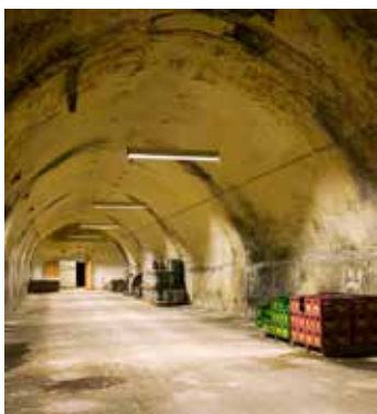
Kælderen under Rød Lagerbygning.
