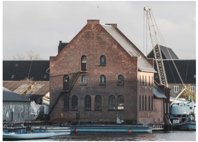
Kedel- og maskinhuset, som har bevaringsværdi 3. Foto: COBE.
