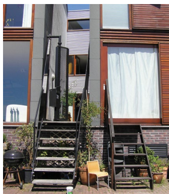
Boliger i stueetagen med trapper. Reference: Amsterdam.
