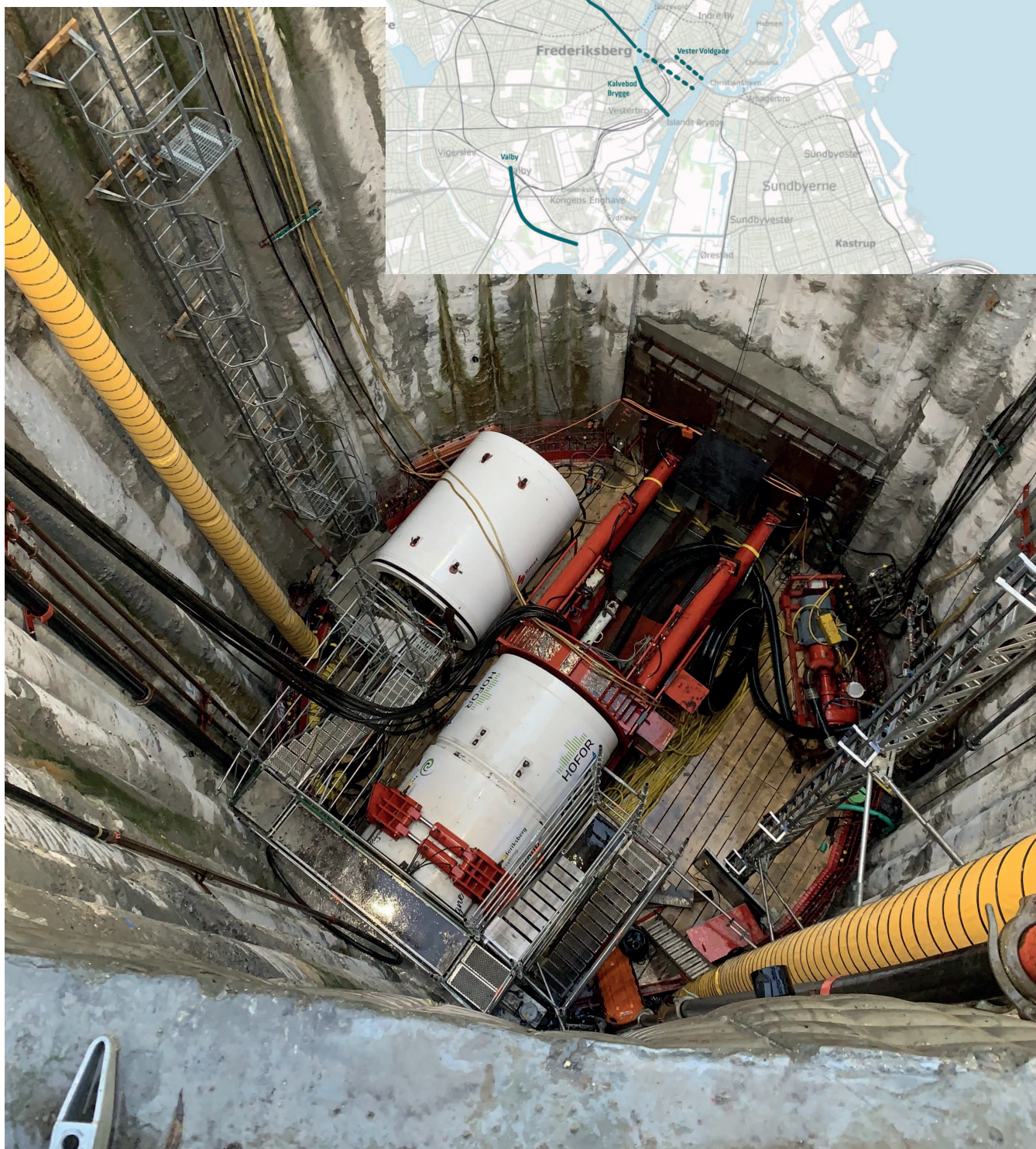
↑ Kalvebod Brygge Skybrudstunnel, foto HOFOR
