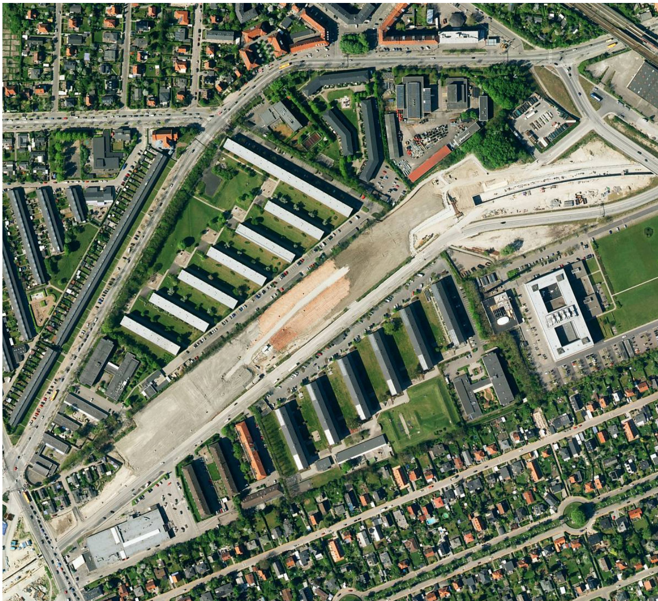
Tunnel under anlæg 2017
