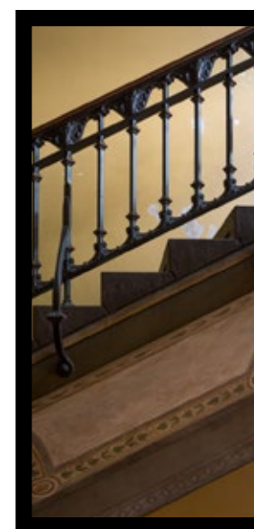
Detalje fra trappen i Stormgade 18. Foto: Torben Eskerud
