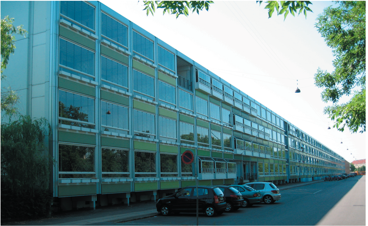
Eksisterende vestfacade, set fra nord Ryholtgård
