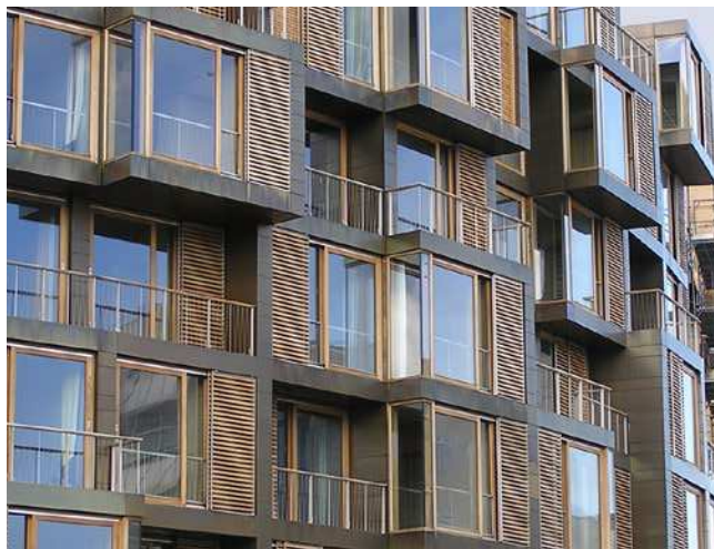
Eksempel på byggeri med stor variation ved udformning af vinduespartier og altaner. (Kilde Københavns Kommune)
