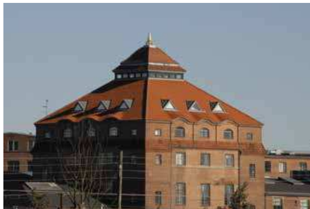
Sukkertoppen, der i dag huser Teknisk Skole, har høj bevaringsværdig og fungerer som vartegn
